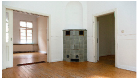
4 Blick in die Wohnräume im Erdgeschoss vor der Sanierung 2014. In die bauzeitliche Ofennische wurde um 1930 ein Kachelofen eingebaut.
