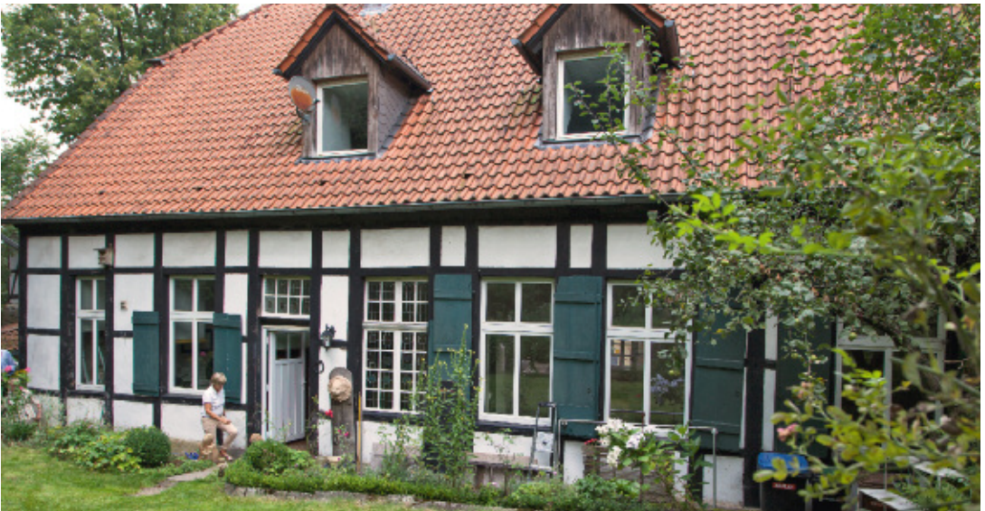
1 Ansicht der Gartenseite des Hauses im Sommer 2014, die beiden nachträglich aufgesetzten Dachgauben wurden bei der Sanierung wieder entfernt.
