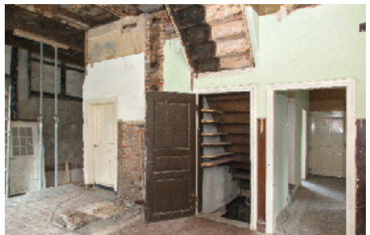
3 Der ehemalige Küchenraum während der Bauphase 2015. Gut zu erkennen sind die Spuren der ehemaligen Kamine.
